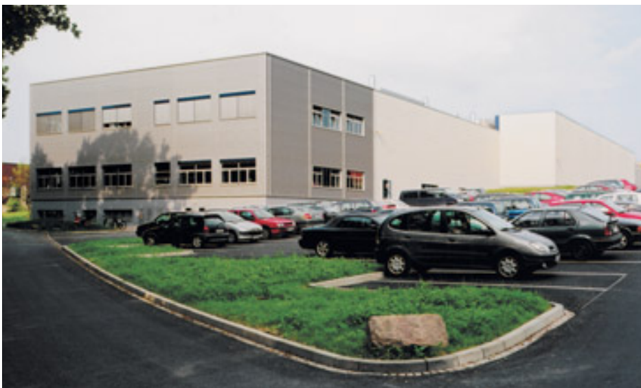
Zum Hettich-Betriebsgebäude an der A8 gehört neben Produktionshalle und Pufferlager auch ein Ausbildungszentrum. Bilder: Hettich
